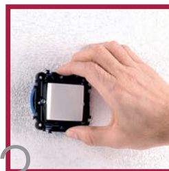
3 Introduisez-le dans le boîtier encastré
